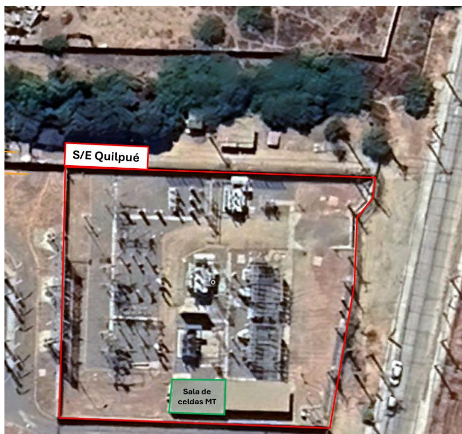
Figura 8-10: Imagen satelital de la disposición de los equipos en la S/E Quilpué.
