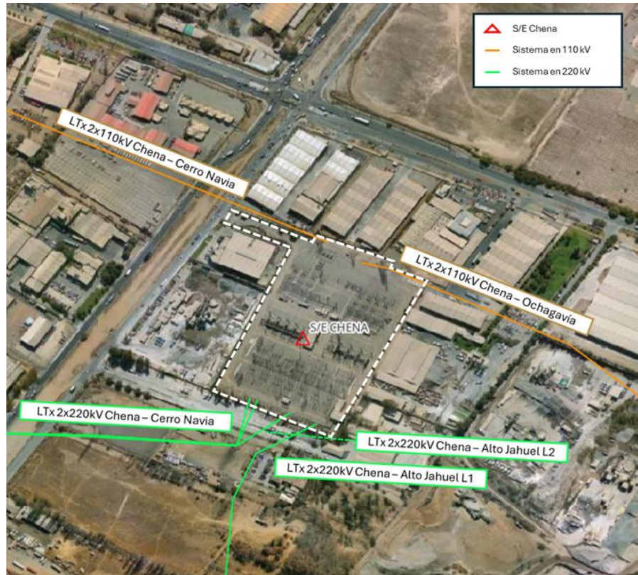
Figura 8-31: Vista aérea de S/E Chena y sus predios colindantes.
