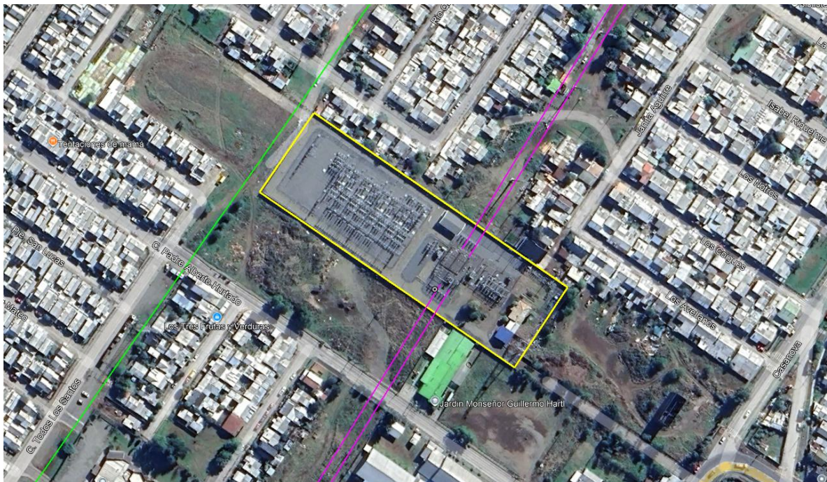
Figura 8-41: Subestación Pitrufquén y sus alrededores.
