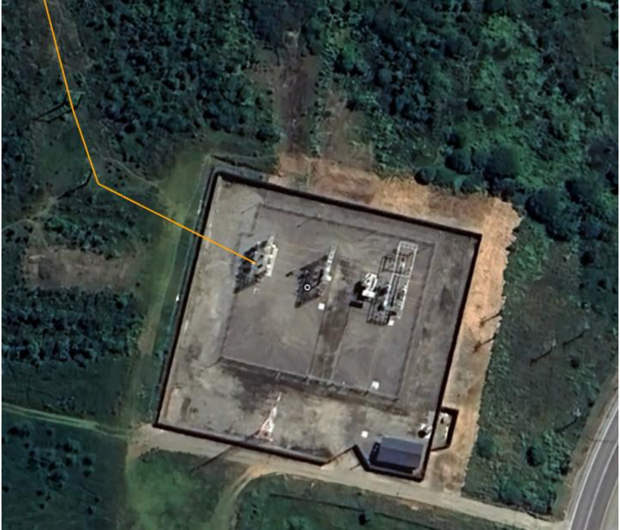
Figura 8-52: Subestación Calbuco y sus alrededores.
