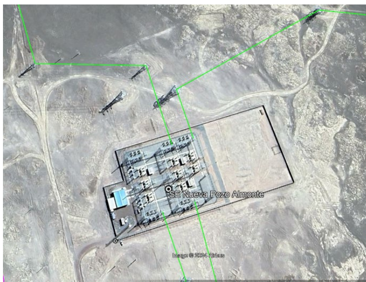
Figura 34. Subestación Nueva Pozo Almonte 220 kV
