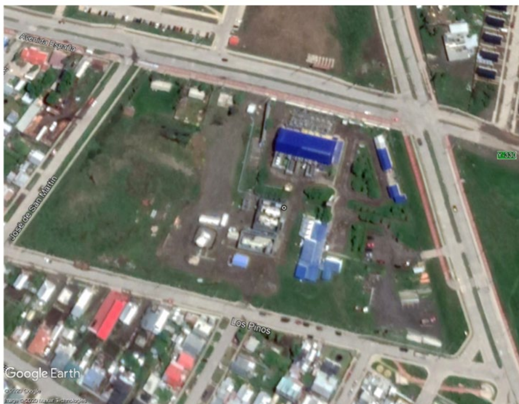
Figura 131. Sector emplazamiento Central, Subestación y Unidad de Punta - Puerto Natales
