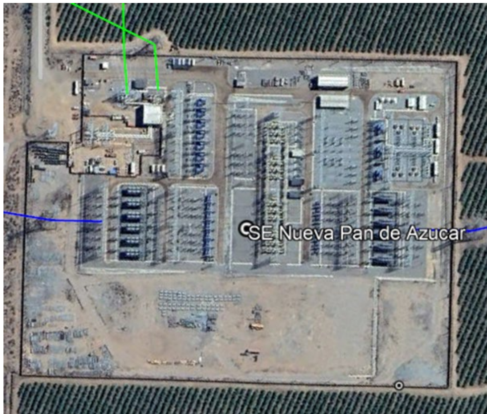
Figura 86. Subestación Nueva Pan de Azúcar 220 kV
