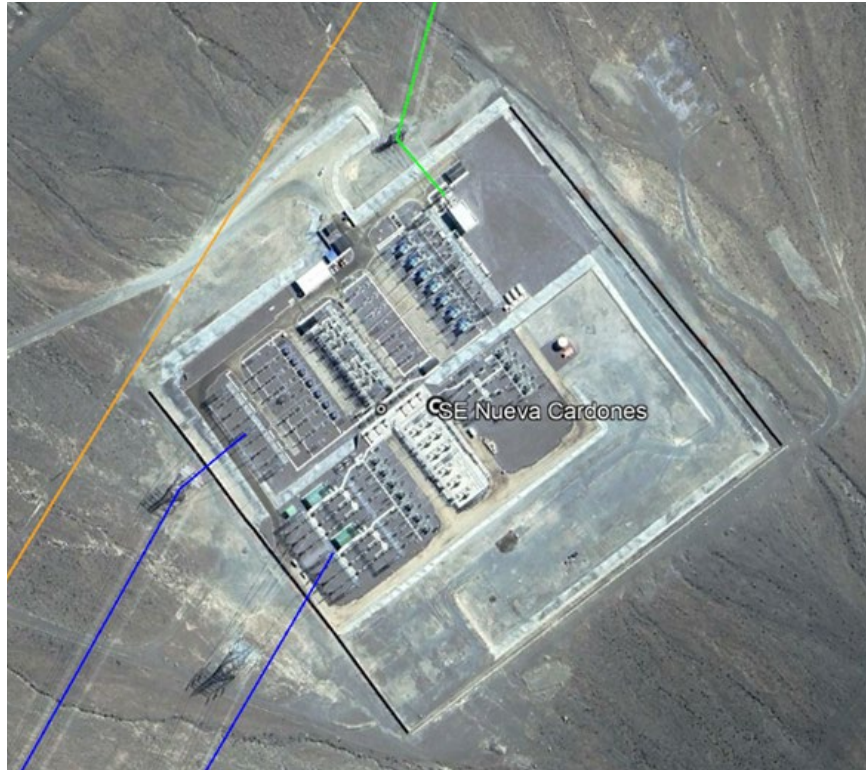
Figura 76. Subestación Nueva Cardones 220 kV
