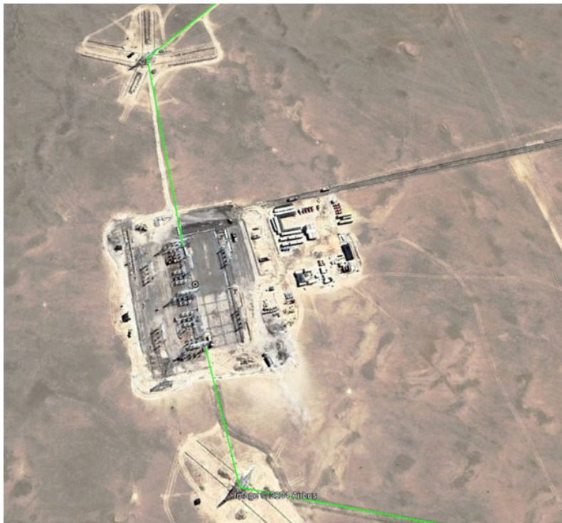
Figura 24. Subestación Roncacho 220 kV
