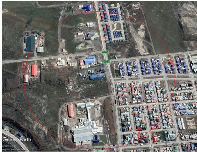
Figura 135. Sector emplazamiento Central y Subestación – Porvenir
