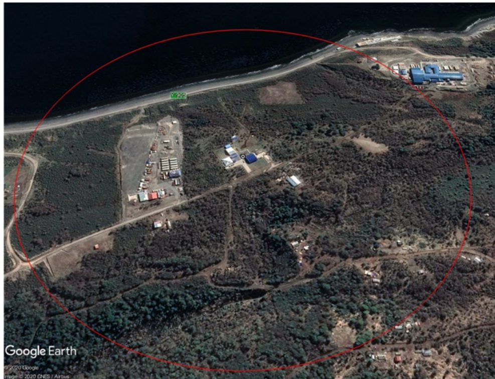
Figura 138. Sector emplazamiento Central y Subestación - Puerto Williams
