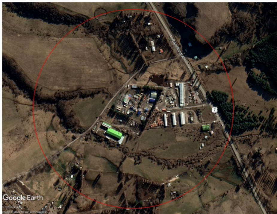
Figura 143. Sector emplazamiento Central y Subestación – Tehuelche (SSMM Aysén)
