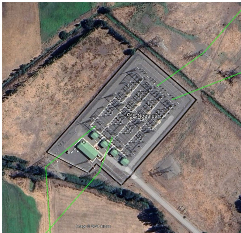
Figura 91. Subestación Nogales 220 kV
