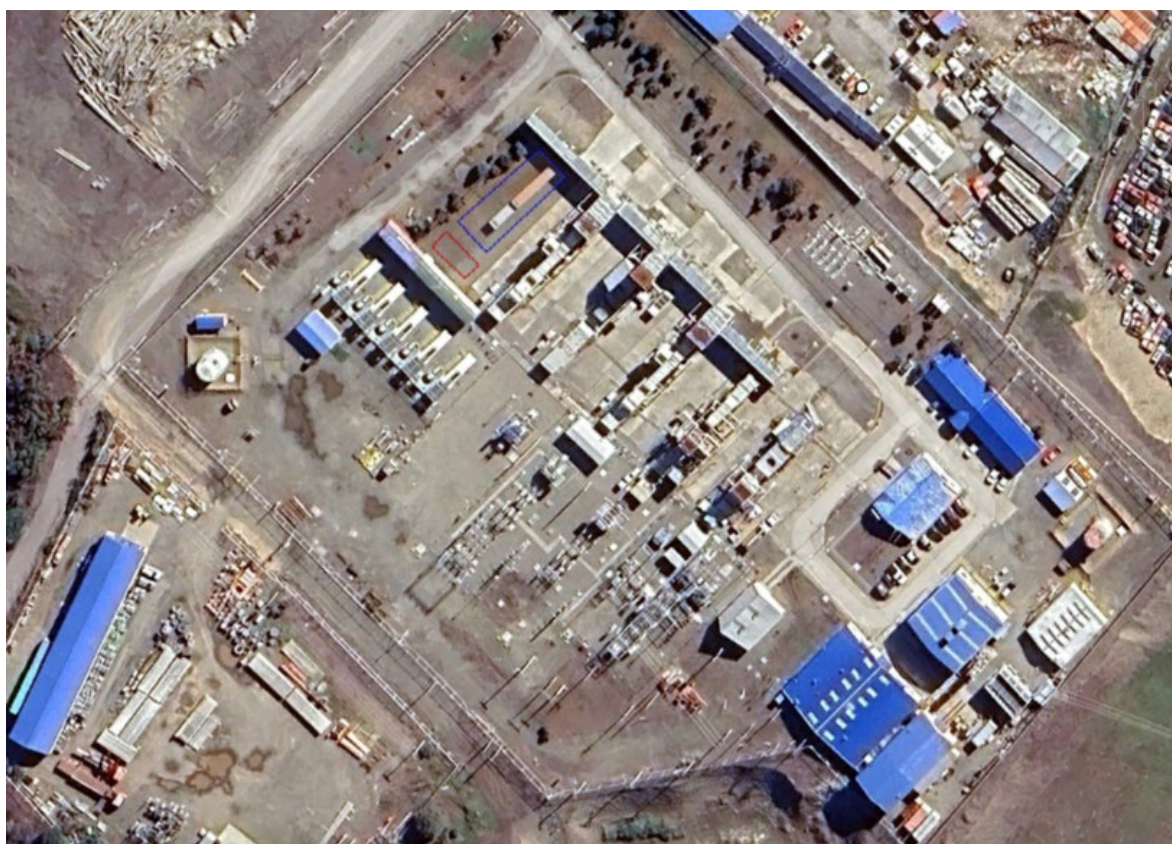
Figura 127. Sector emplazamiento Central, Subestación y Unidad de Punta – Tres Puentes
