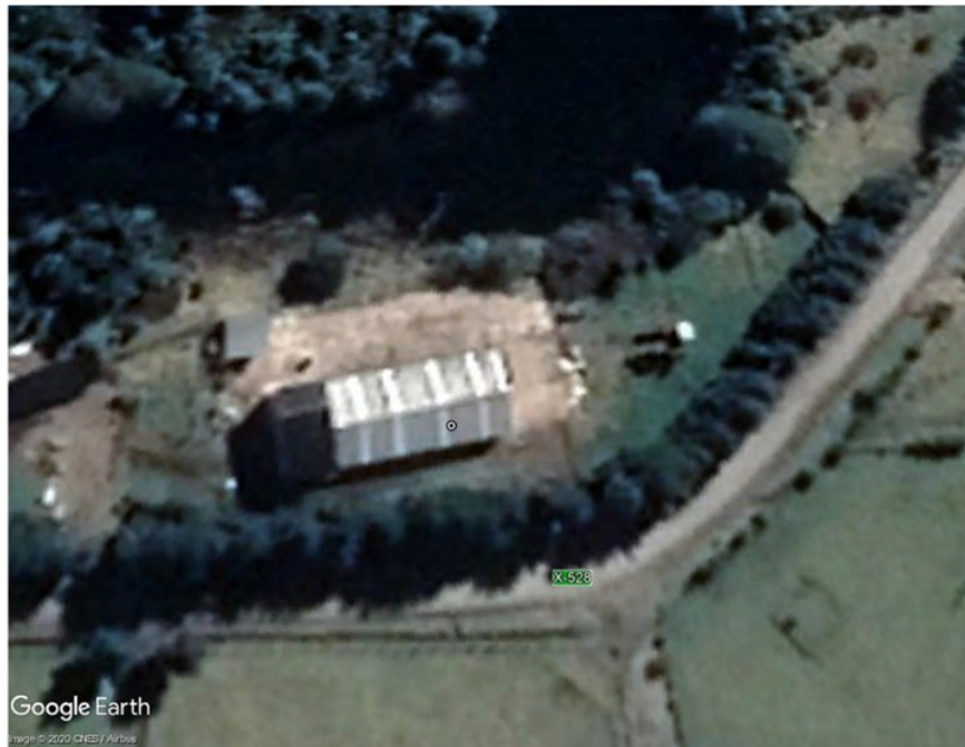
Figura 139. Sector emplazamiento Central, Subestación y Unidad de Punta – Chacabuco (SSMM Aysén)
