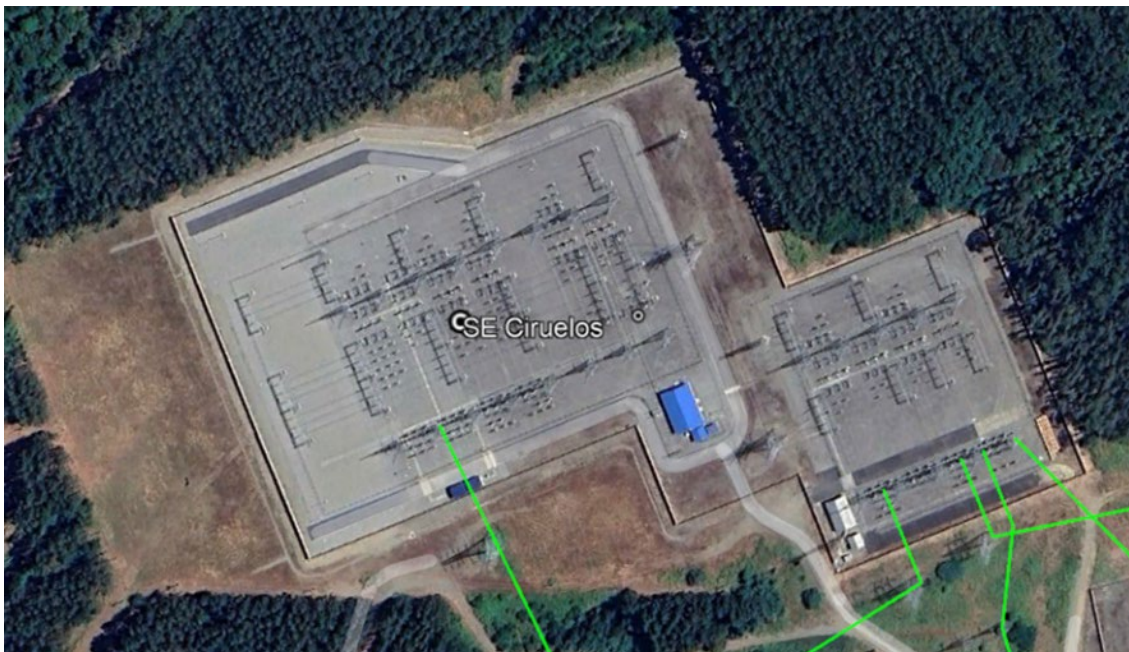
Figura 112. Subestación Ciruelos 220 kV
