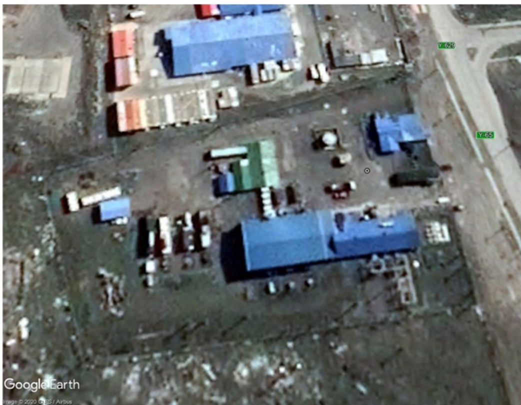
Figura 134. Sector emplazamiento Central, Subestación y Unidad de Punta - Porvenir
