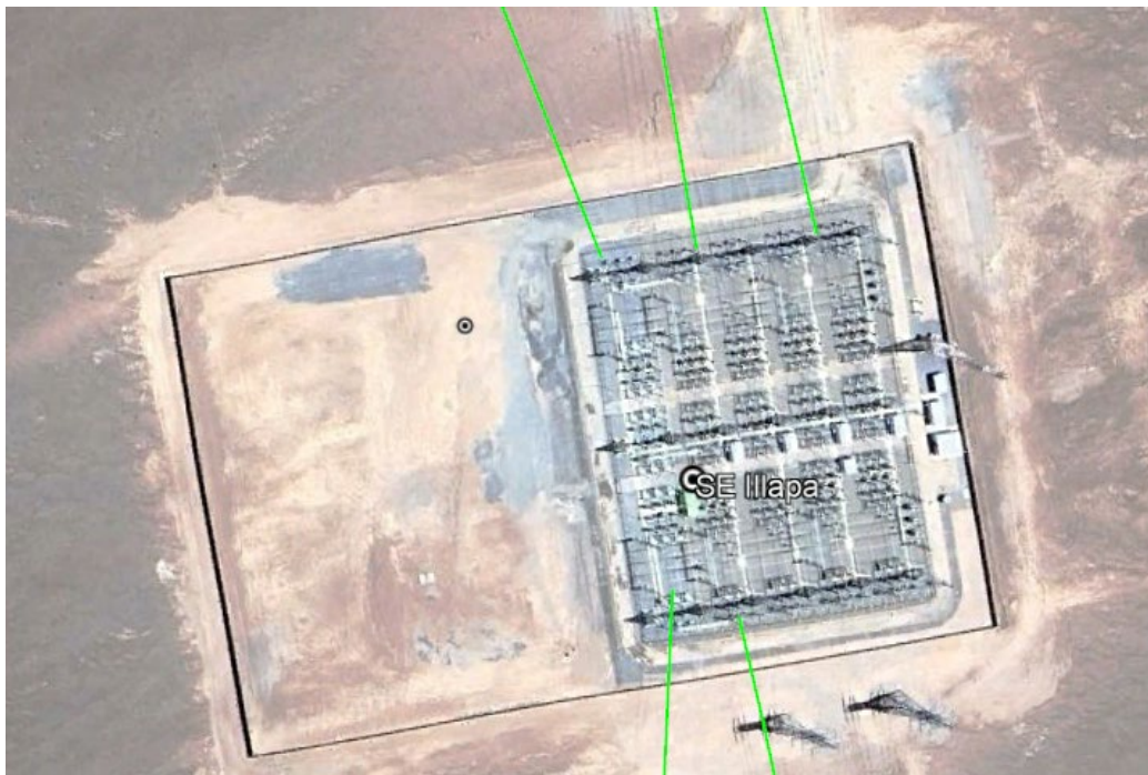
Figura 71. Subestación Illapa 220 kV
