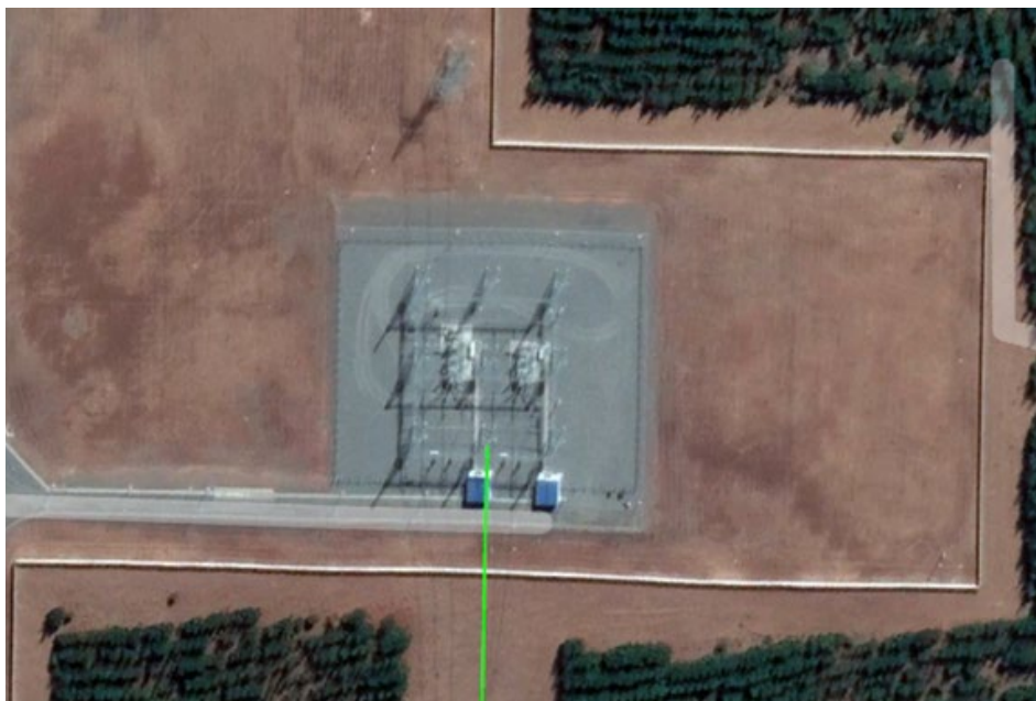
Figura 107. Subestación Entre Ríos 220 kV
