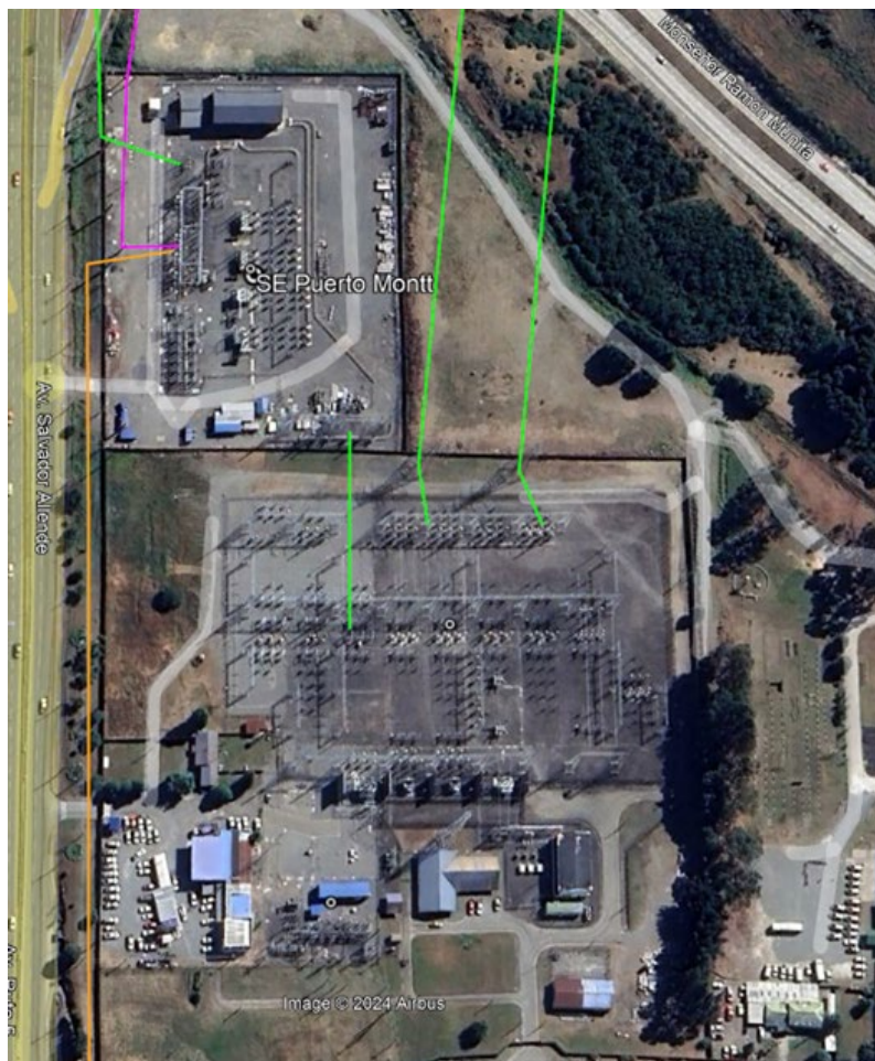
Figura 122. Subestación Puerto Montt 220 kV
