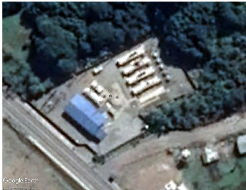
Figura 152. Sector emplazamiento Central, Subestación y Unidad de Punta – Hornopirén
