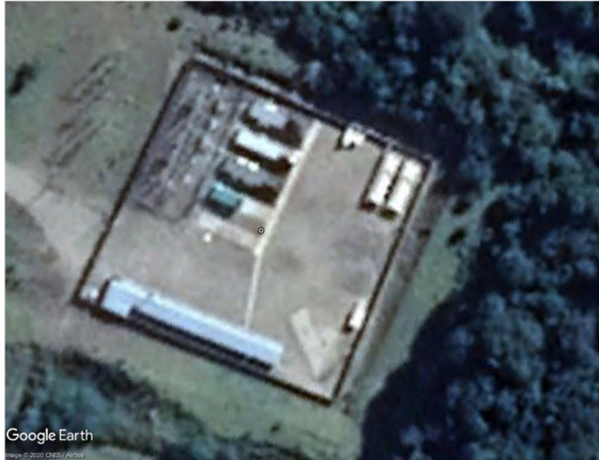
Figura 155. Sector emplazamiento Central, Subestación y Unidad de Punta – Cochamó
