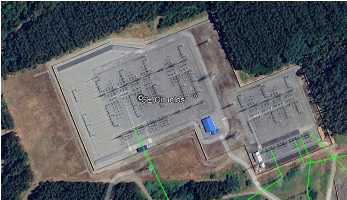
Figura 112: Subestación Ciruelos 220 kV
