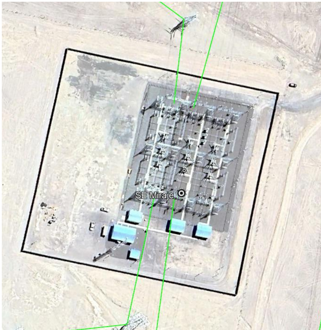
Figura 50: Subestación Miraje 220 kV
