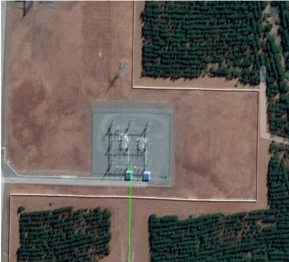
Figura 107: Subestación Entre Ríos 220 kV
