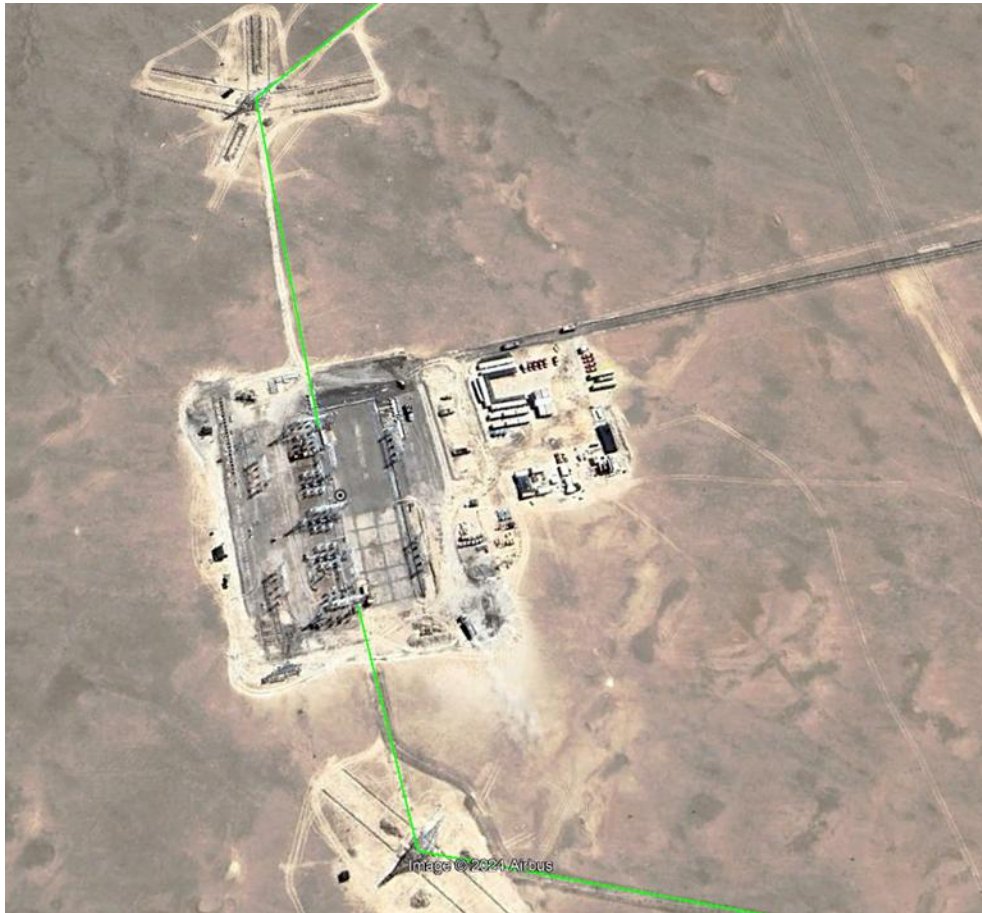
Figura 24: Subestación Roncacho 220 kV
