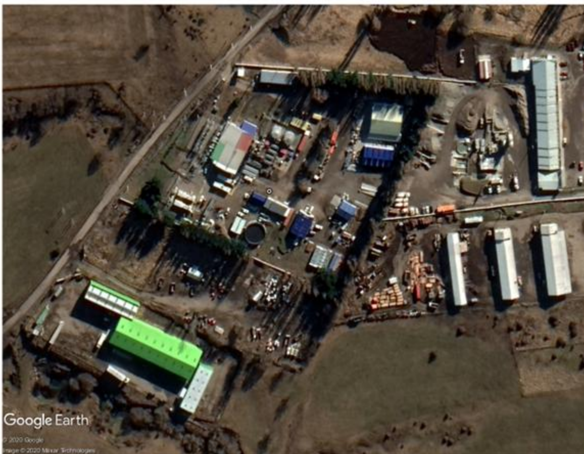
Figura 142: Sector emplazamiento Central, Subestación y Unidad de Punta – Tehuelche (SSMM Aysén)
