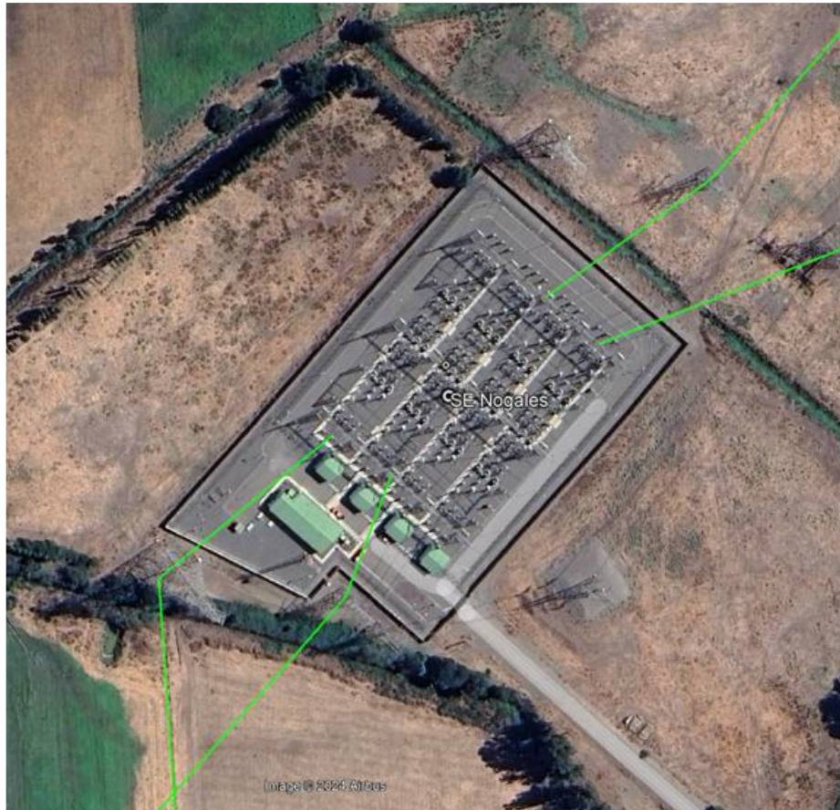
Figura 91: Subestación Nogales 220 kV
