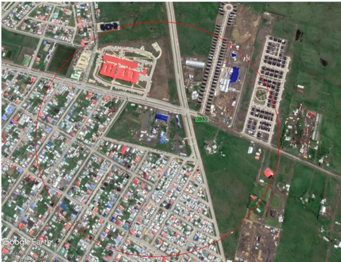
Figura 132 : Sector emplazamiento Central y Subestación - Puerto Natales
