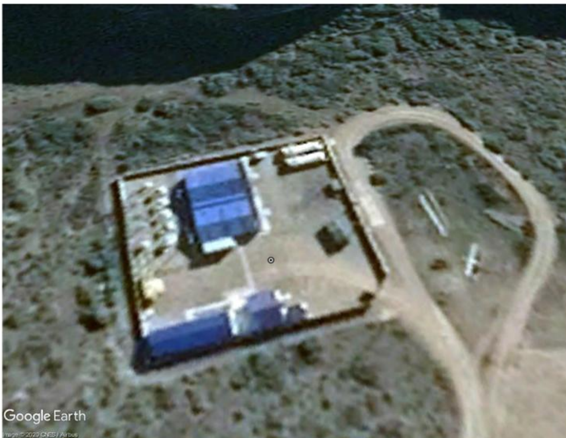
Figura 147: Sector emplazamiento Central, Subestación Chile y Unidad de Punta – Chile Chico (SSMM General Carrera)
