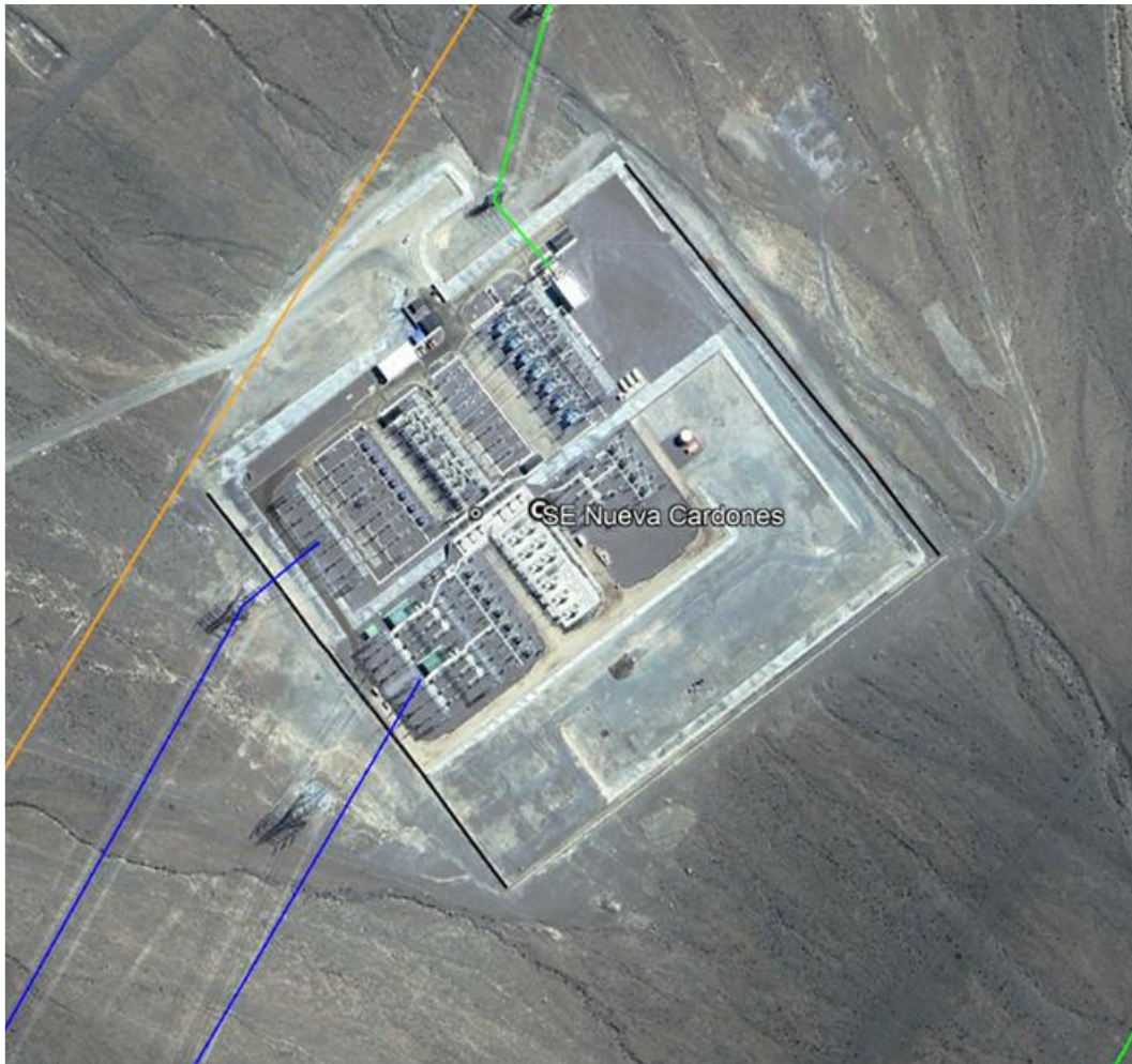
Figura 76: Subestación Nueva Cardones 220 kV
