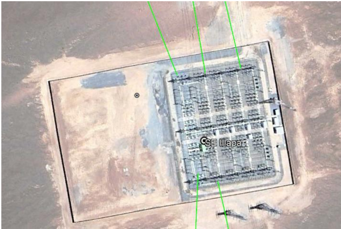
Figura 71: Subestación Illapa 220 kV
