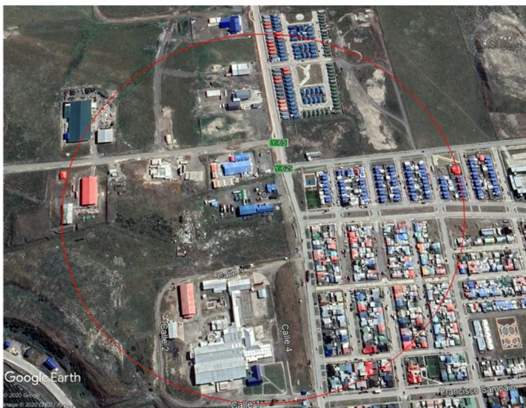
Figura 135: Sector emplazamiento Central y Subestación - Porvenir
