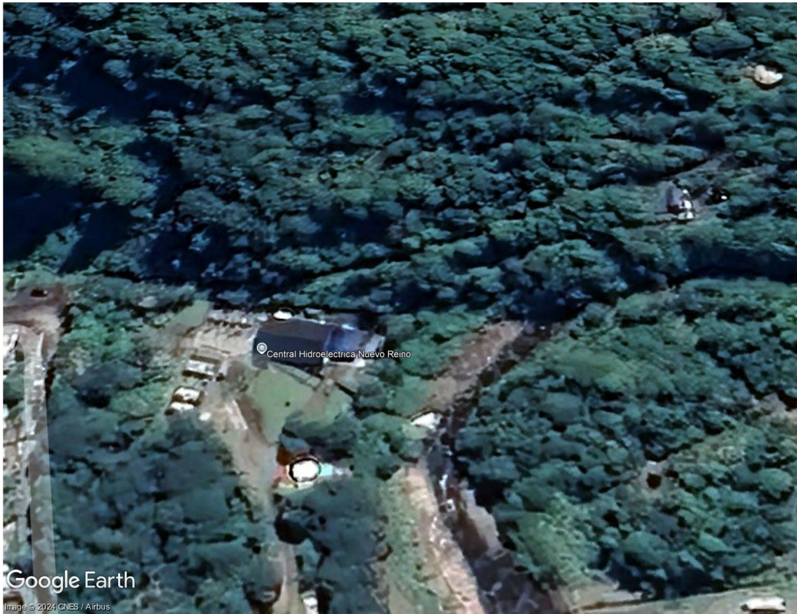
Figura 150: Sector emplazamiento Central, Subestación y Unidad de Punta – Nuevo Reino (SSMM Puerto Cisnes)
