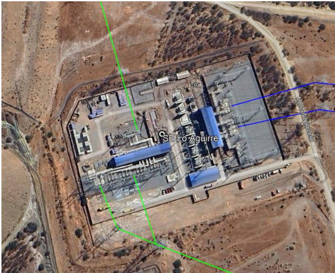
Figura 96: Subestación Lo Aguirre 220 kV
