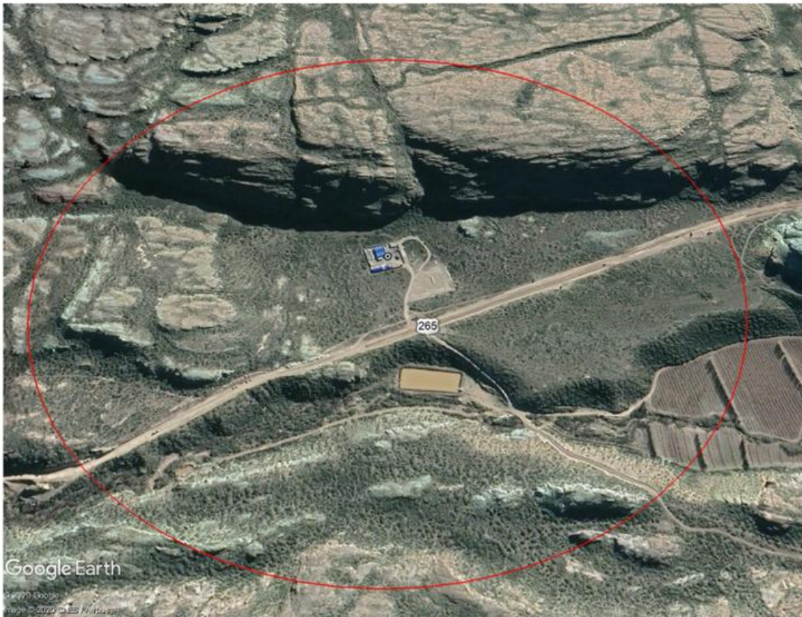
Figura 148: Sector emplazamiento Central y Subestación - Chile Chico (SSMM General Carrera)
