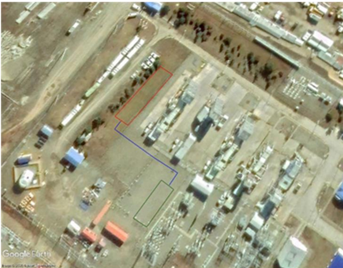
Figura 127: Sector emplazamiento Central, Subestación y Unidad de Punta – Tres Puentes
