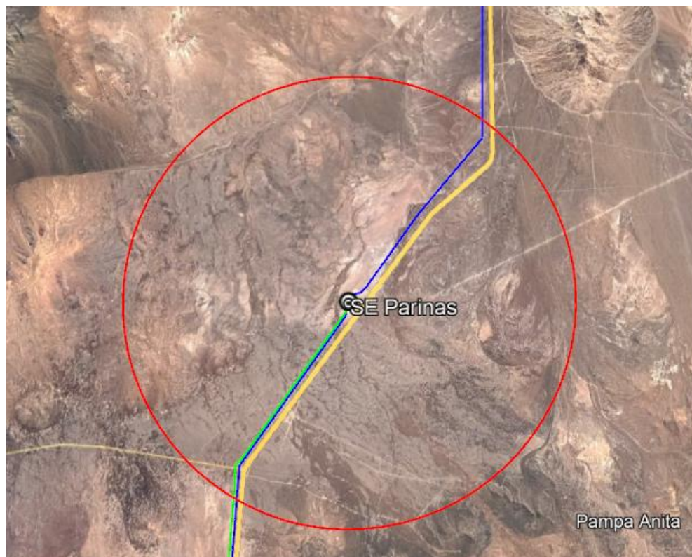
Figura 62: Subestación Parinas 220 kV y sector posible emplazamiento Unidad de Punta
