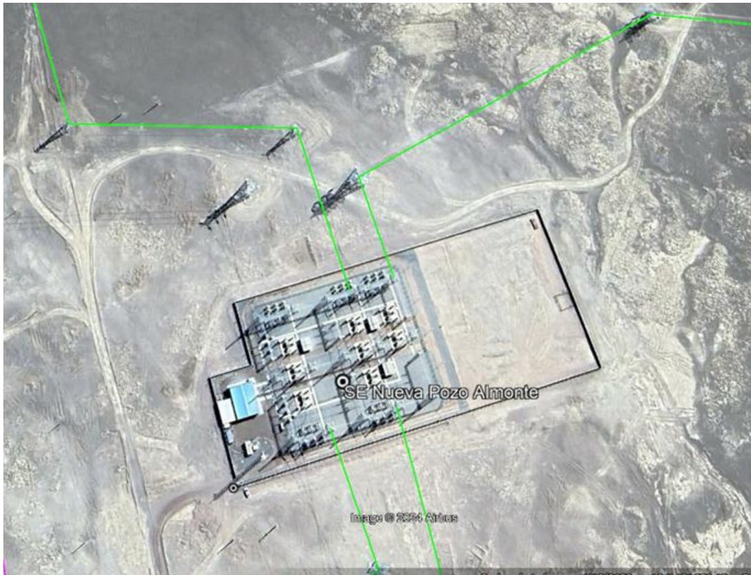
Figura 34: Subestación Nueva Pozo Almonte 220 kV
