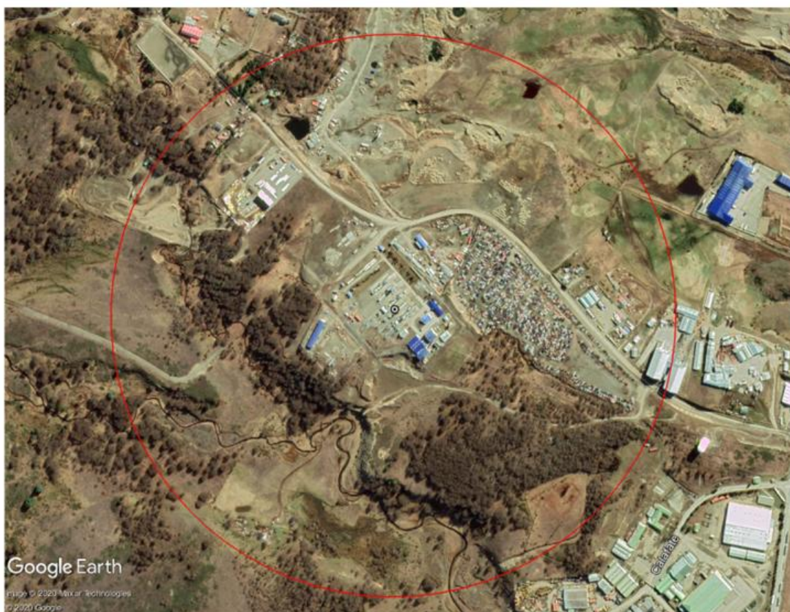
Figura 128: Sector emplazamiento Central y Subestación - Tres Puentes
