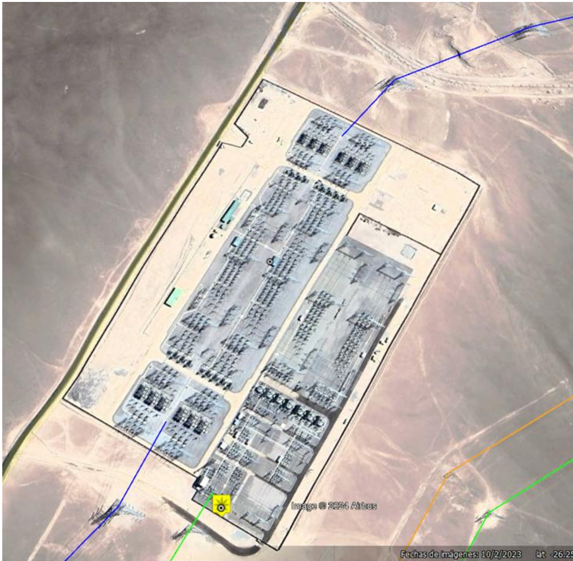
Figura 65: Subestación Cumbres 220 kV
