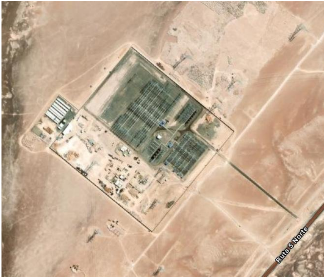
Figura 60: Subestación Parinas 220 kV
