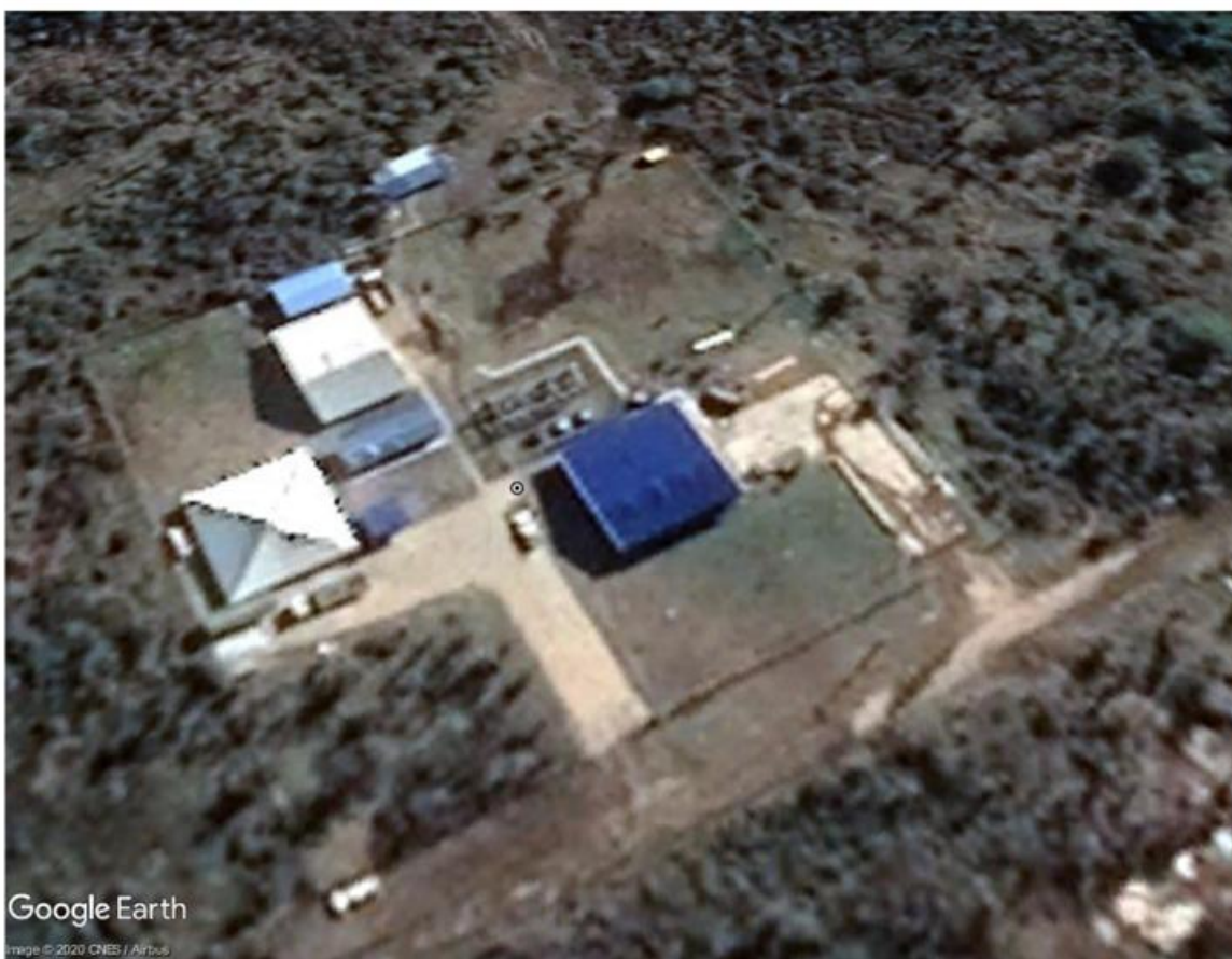
Figura 137: Sector emplazamiento Central, Subestación y Unidad de Punta - Puerto Williams
