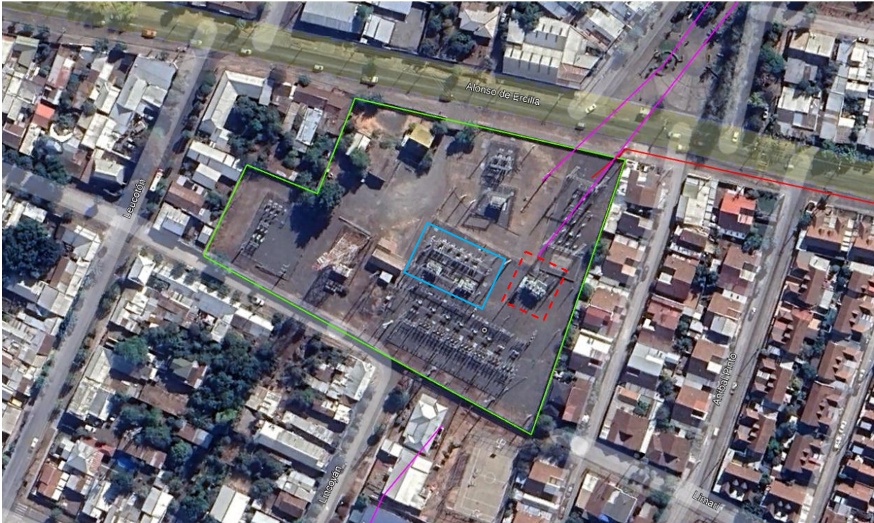
Figura 8-122: Emplazamiento de la S/E Chillán dentro de la ciudad del mismo nombre. Se destacan los transformadores 154/66 kV (cuadrilátero rojo, línea punteada en la figura) y 66/15 kV (cuadrilátero celeste, línea continua en la figura)
