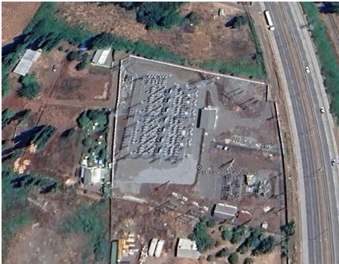
Figura 8-134: Vista aérea S/E Padre Las Casas
