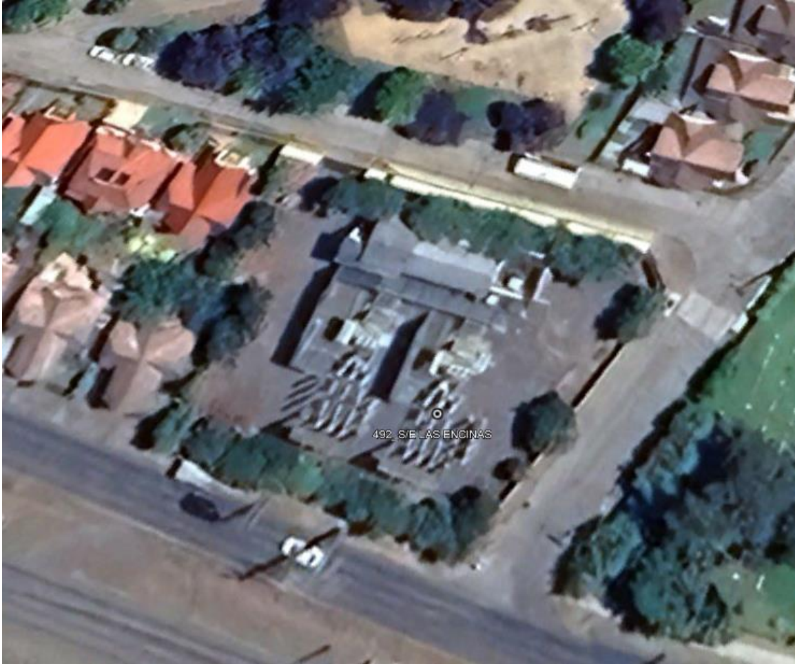
Figura 8-130: Vista aérea S/E Las Encinas, Temuco
