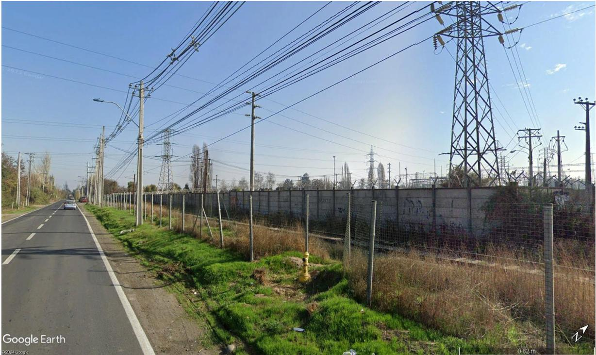
**Figura 8-34: vista de la salida del patio de media tensión de la S/E Fátima. Se observa la limitada posibilidad de construir nuevos alimentadores, debido a la abundancia de conductores tendidos en el sector.**
