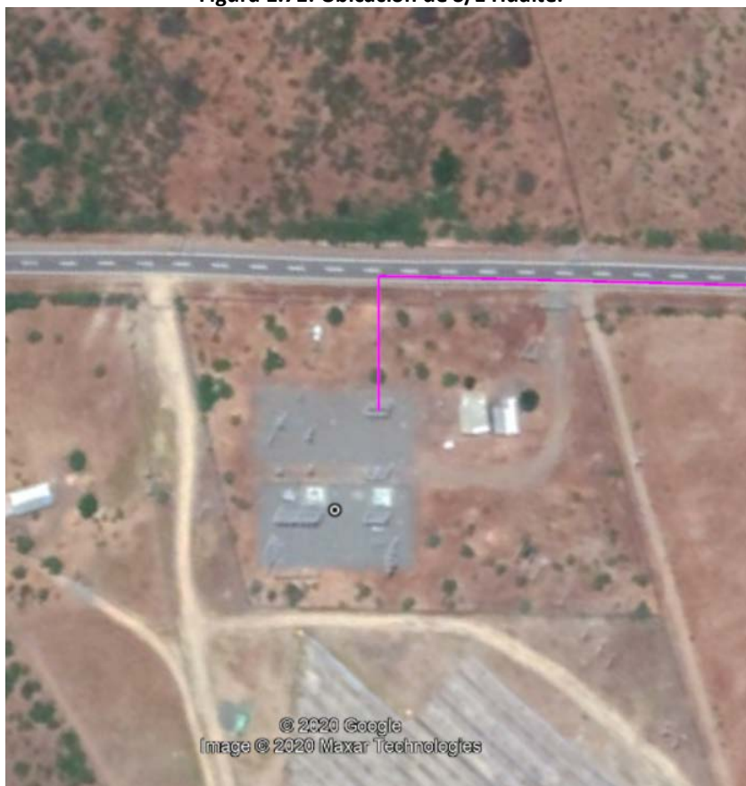
Figura 1.71: Ubicación de S/E Hualte.
