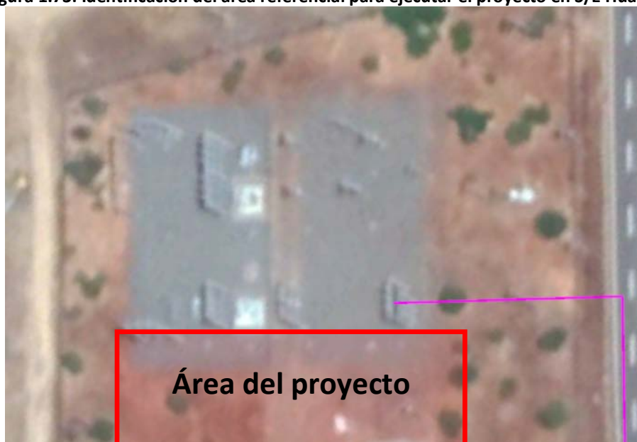
Figura 1.73: Identificación del área referencial para ejecutar el proyecto en S/E Hualte.
