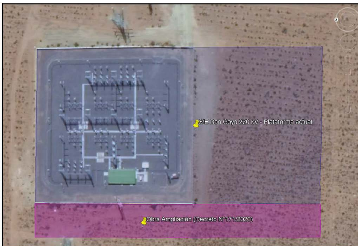
Figura 1.18: Imagen de la Subestación Don Goyo con la zona donde se ejecutará la obra del Decreto Exento N°171.
