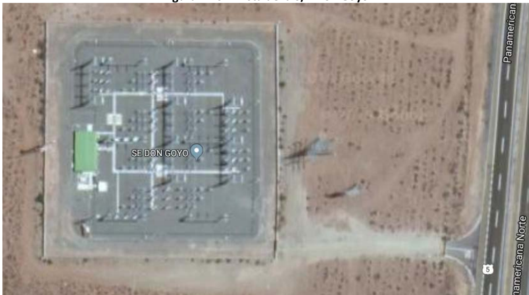
Figura 1.107: Vista de la S/E Don Goyo.
