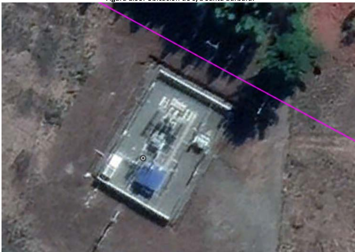
Figura 1.93: Ubicación de S/E Santa Bárbara.
