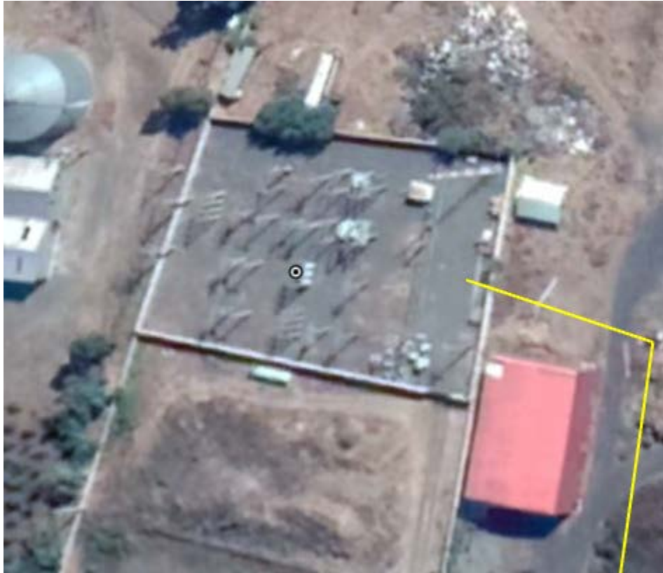
Figura 1.120: Vista de la S/E Santa Elisa.
