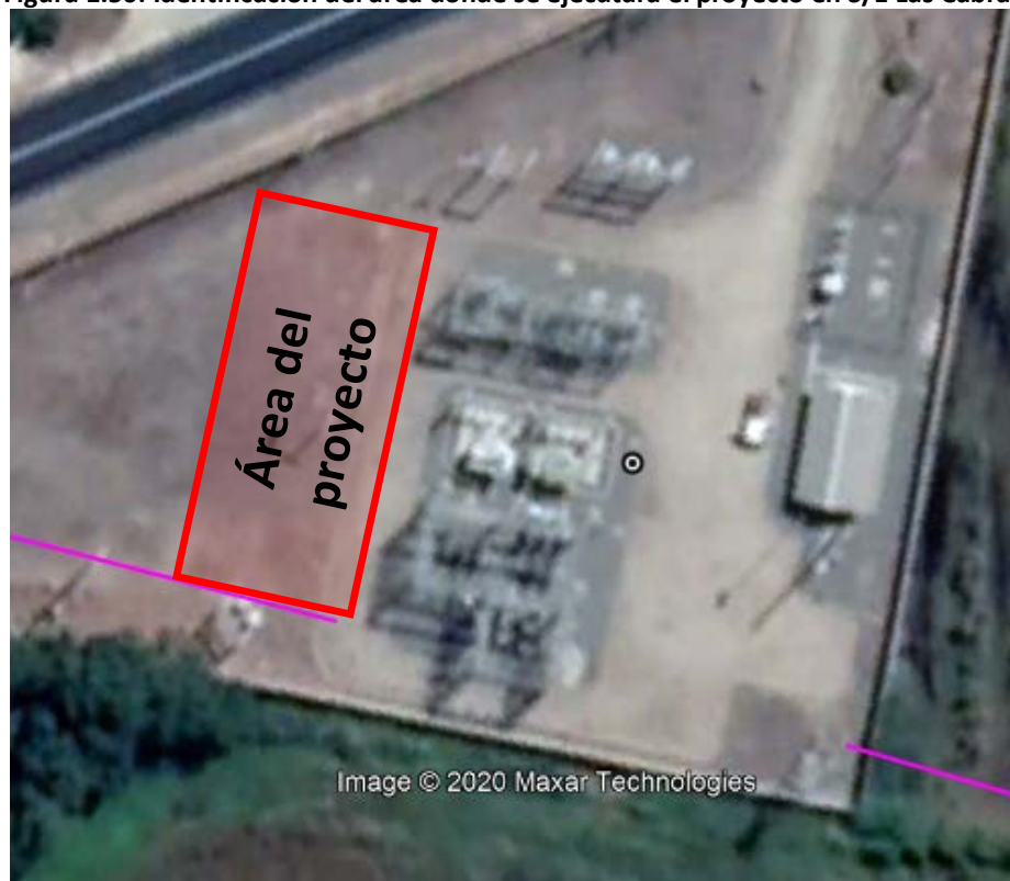
Figura 1.50: Identificación del área donde se ejecutará el proyecto en S/E Las Cabras.
