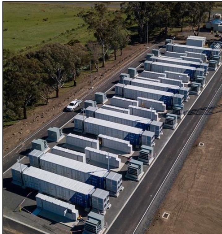
Figura N° 4.14 Sistema de Almacenamiento mediante Baterías
