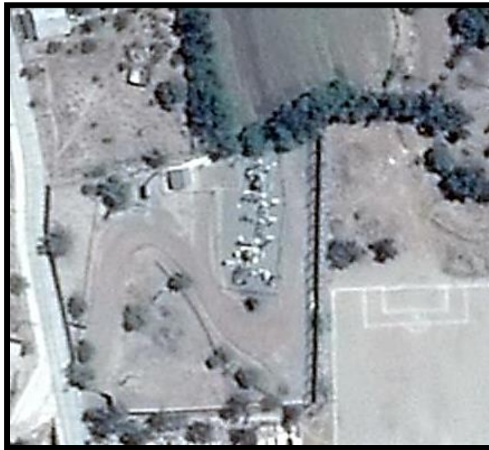
Figura 6.10 Subestación Monte Patria, Vista Aérea
