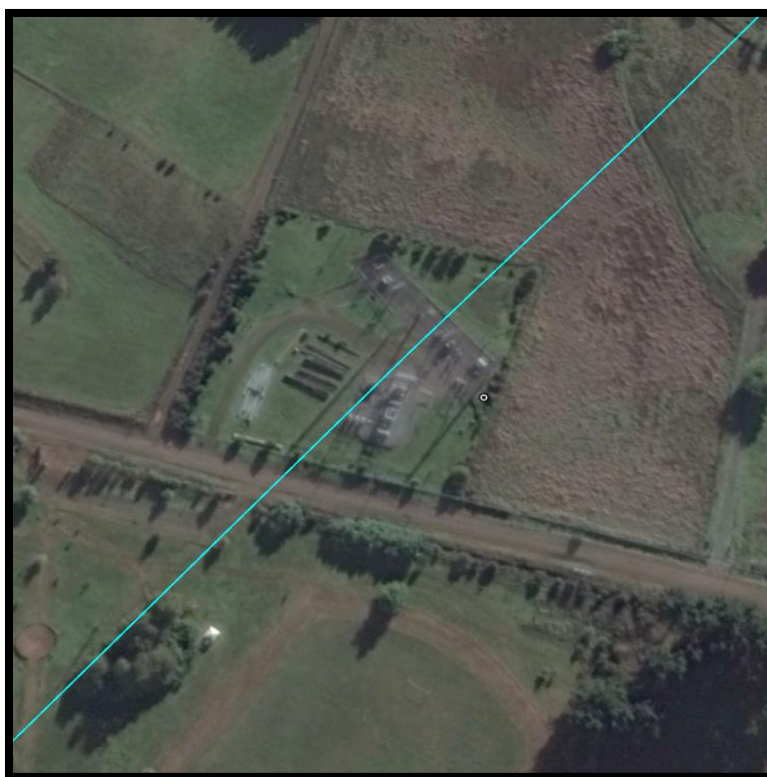
Figura 6.136 Subestación Pillanlelbún, Vista Aérea.
