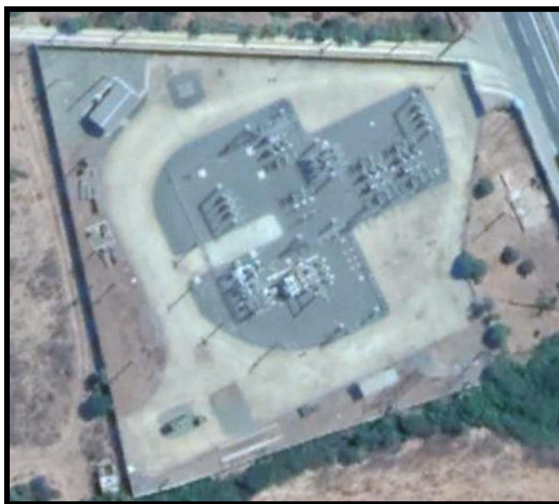
Figura 6.13 Subestación Quinquimo, Vista Aérea
