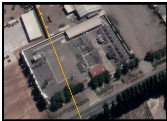
Figura 6.43 Ubicación de S/E Batuco 110/23 kV
