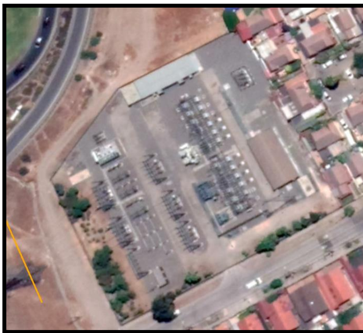
Figura 6.55 Ubicación de S/E Pajaritos 110/23/12,5 kV
