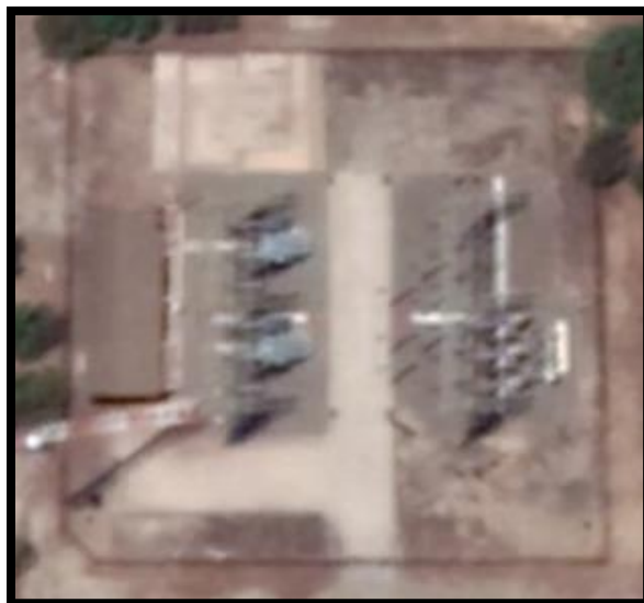
Figura 6.49 Ubicación de S/E Lo Aguirre 110/12,5 kV
