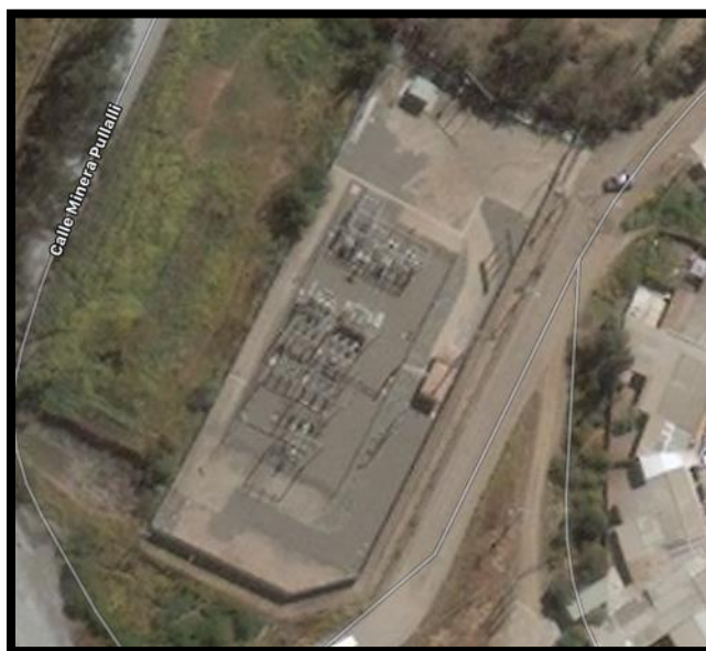
Figura 6.16 Subestación Cabildo, Vista Aérea
