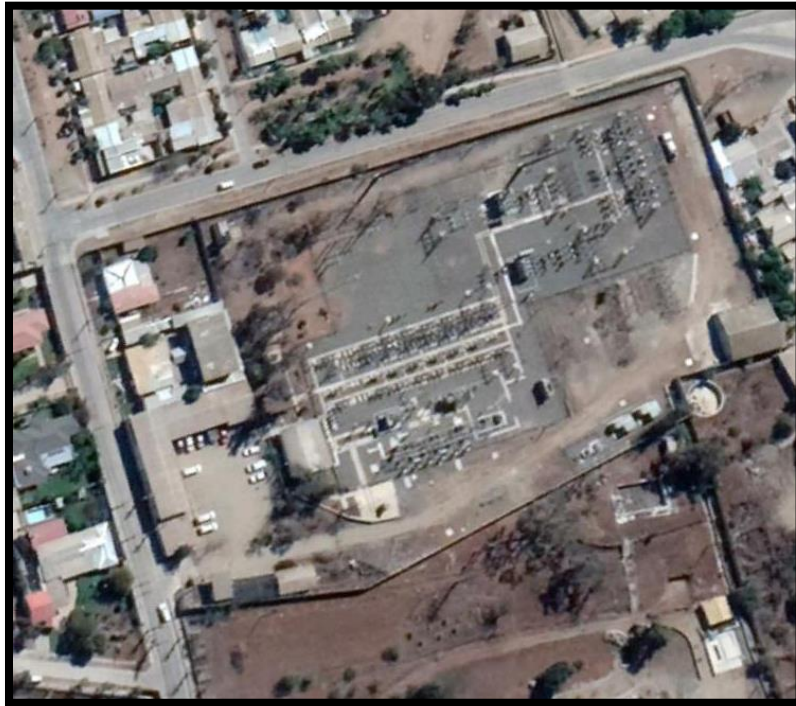
Figura 6.19 Subestación Ovalle, Vista Aérea
