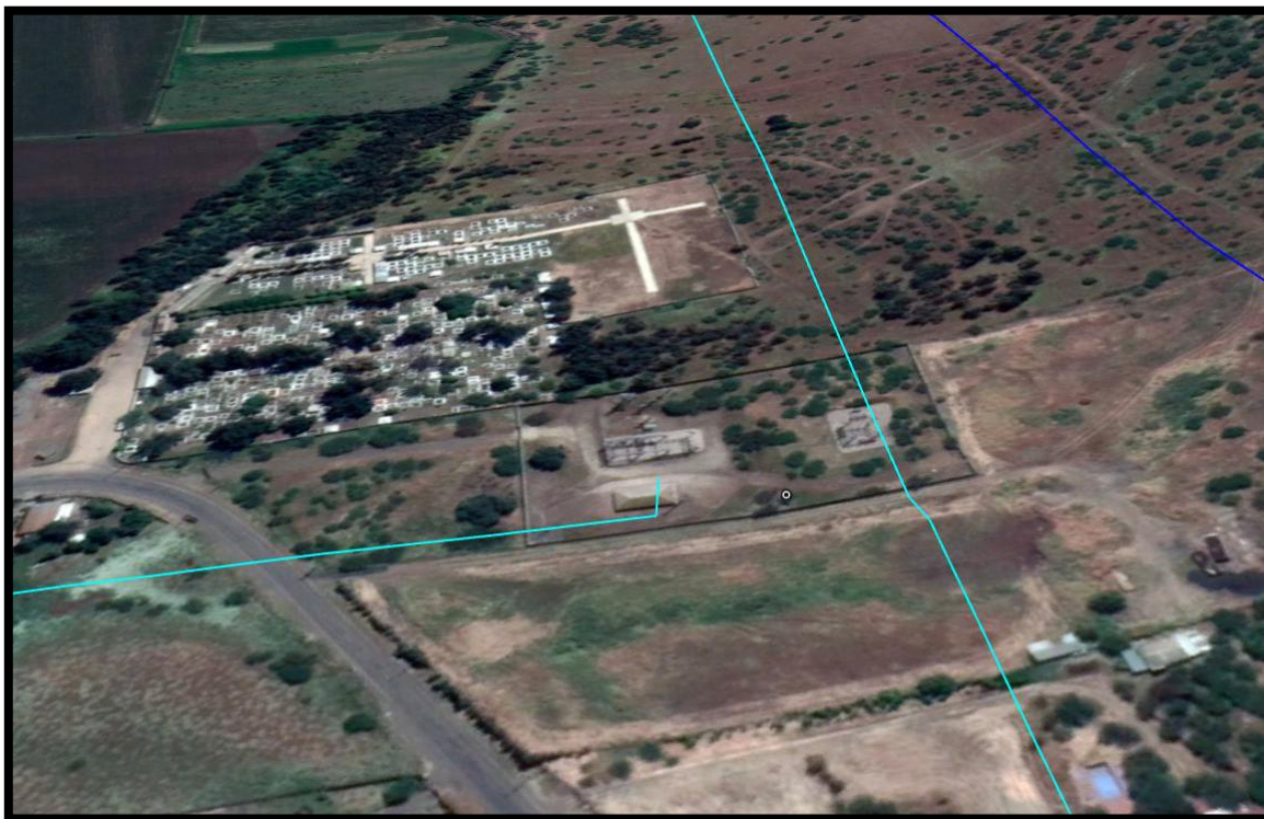
Figura 6.89 Ubicación de la S/E Pelequén
