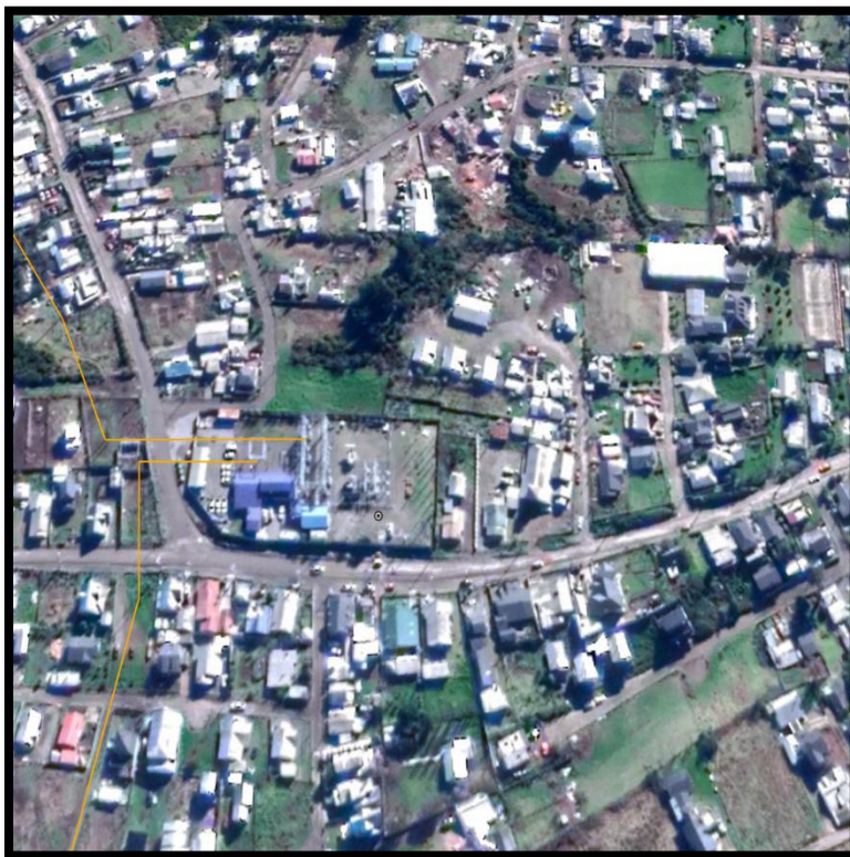
Figura 6.143 Ubicación de la S/E Castro
