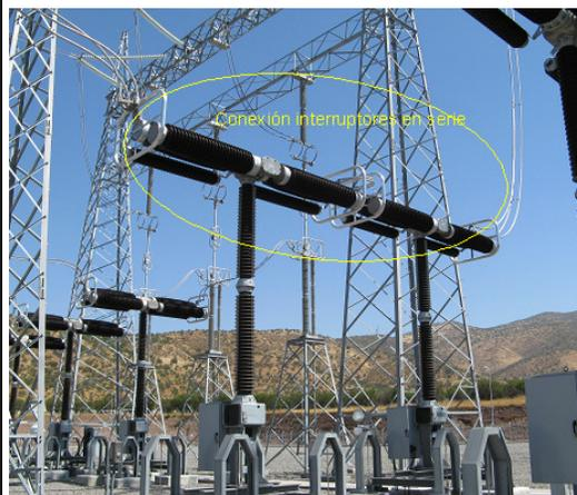
En la siguiente figura se muestra un interruptor de 3 cámaras en el patio de 500 kV de la S/E Alto Jahuel, formado por 3 interruptores de una cámara en serie:
