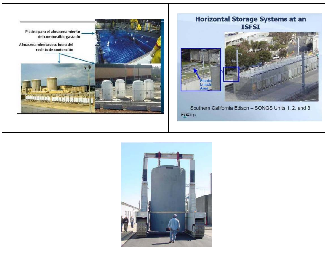
Figura 3.7 - Piscina de almacenamiento del combustible gastado en el recinto de contención de la central nuclear y su almacenamiento en seco en el emplazamiento de la central nuclear. Nótese,
