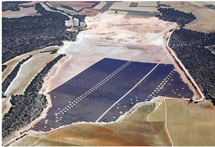
Imagen 3.2 - Central Solar de Cuenca (España), compuesta por 90 mil paneles solares que cubren 80 hectáreas, equivalente a 100 canchas de fútbol, para producir 18 MW.
