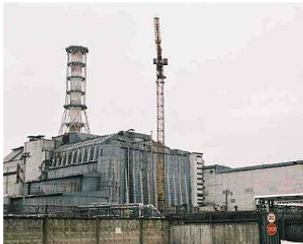
Imagen 4.2 - Unidad 4 de la central nuclear de Chernobyl donde ocurrió el accidente. Se puede apreciar la estructura de hormigón denominada “sarcófago” diseñado para contener el material radioactivo del núcleo del reactor y para una duración de 30 años.
