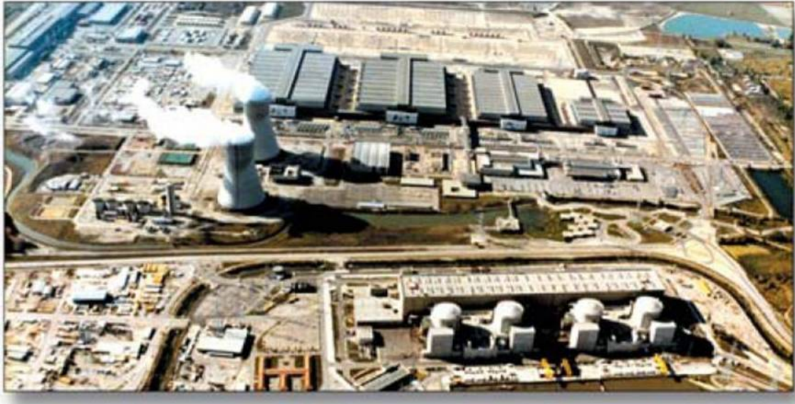
Imagen 3.6 - Planta de enriquecimiento de uranio de Tricastin, Francia. Esta planta garantiza las necesidades de de uranio enriquecido para las centrales nucleares francesas.
