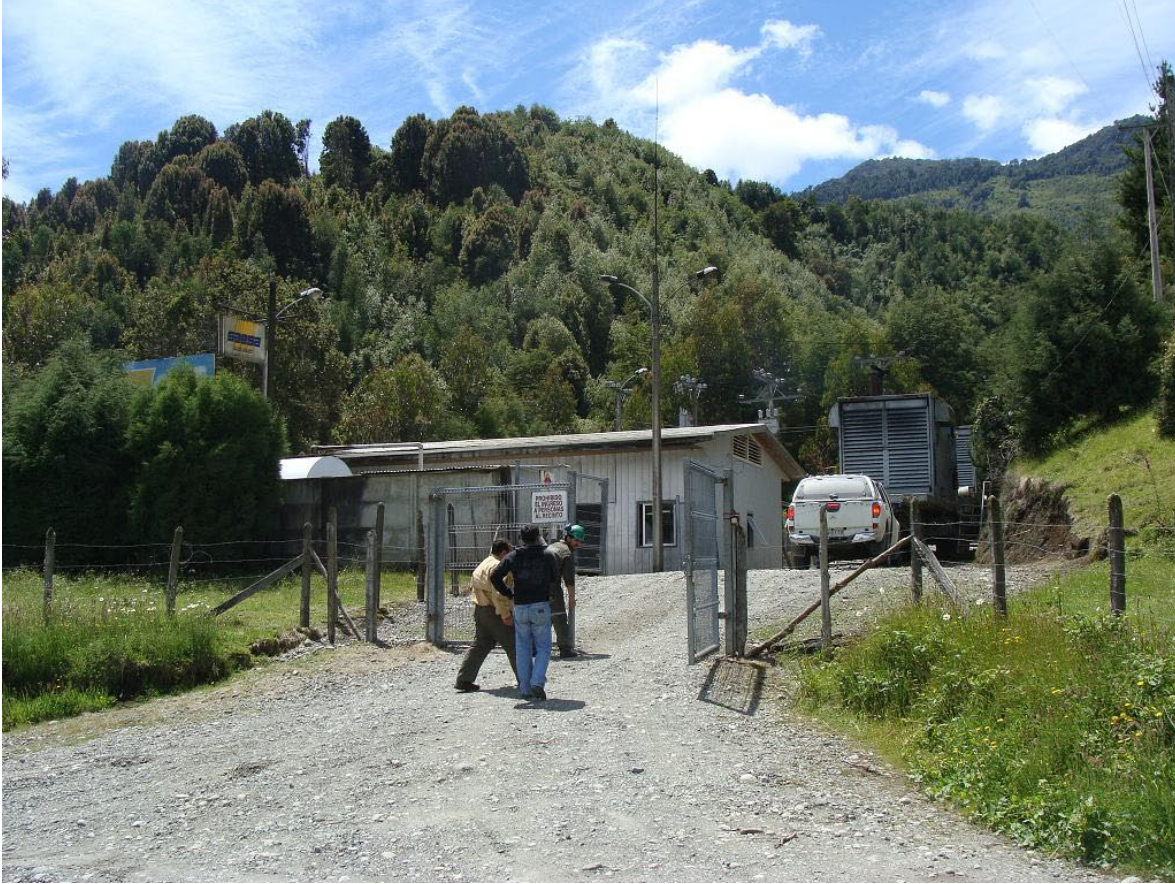
FIGURA N° 2: Central Térmica Cochamó
