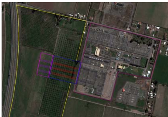
Subestación Alto Jahuel 500 kV
