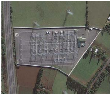
Subestación Cautín 220 kV
