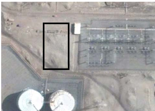
Subestación Tarapacá 220 kV
