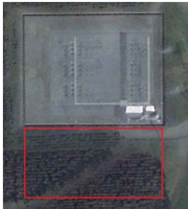
Subestación Ciruelos 220 kV
