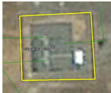
Subestación Carrera Pinto 220 kV
