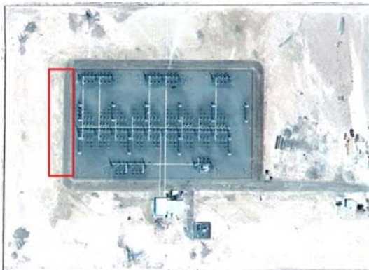
Subestación Lagunas 220 kV
