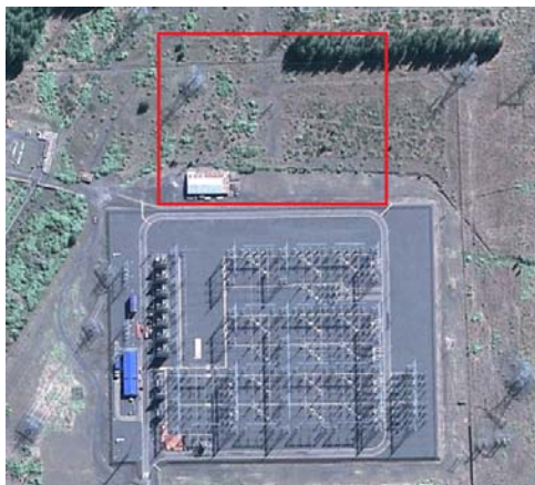
Subestación Charrua 500 kV
