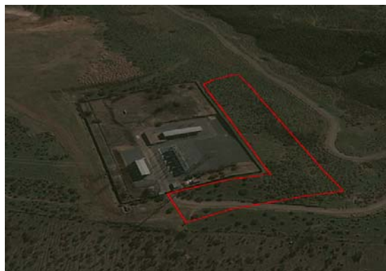
Subestación Los Almendros 500 kV
