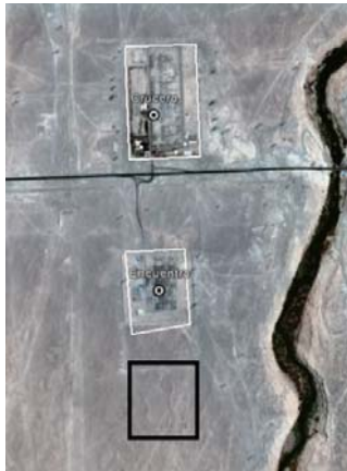
Subestación Nueva Encuentro 500 kV
