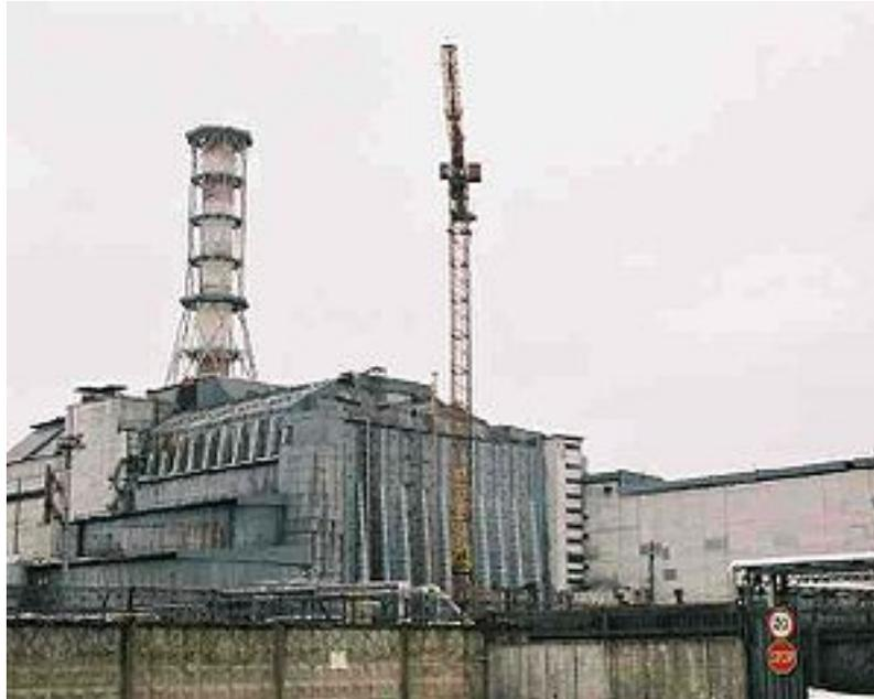
**Imagen 3.2** - Unidad 4 de la central nuclear de Chernobyl donde ocurrió el accidente. Se puede apreciar la estructura de hormigón denominada “sarcófago” diseñado para contener el material radioactivo del núcleo del reactor y para una duración de 30 años.
