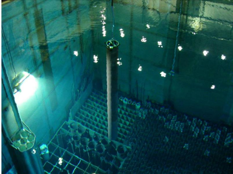
**Imagen 4.2** - *Piscina típica para el almacenamiento del combustible nuclear gastado.*
