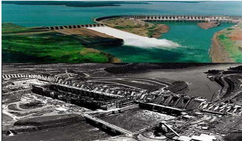
**Imagen 7.3** - Represa Hidroeléctrica de Itaipú. El lago artificial tiene 29 millones de  $m^3$  de agua, con unos 200 Km de extensión en línea recta y un área aproximada de 1.400  $Km^2$ . La potencia instalada es 12.900 MW, con 18 turbinas generadoras de 700 MW cada una.
