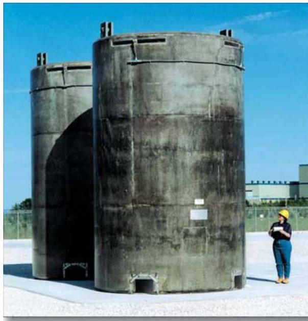
**Imagen 4.3** - Almacenamiento en seco del combustible nuclear gastado. Nótese que no es necesario ropa especial para estar en las cercanías del contenedor.
