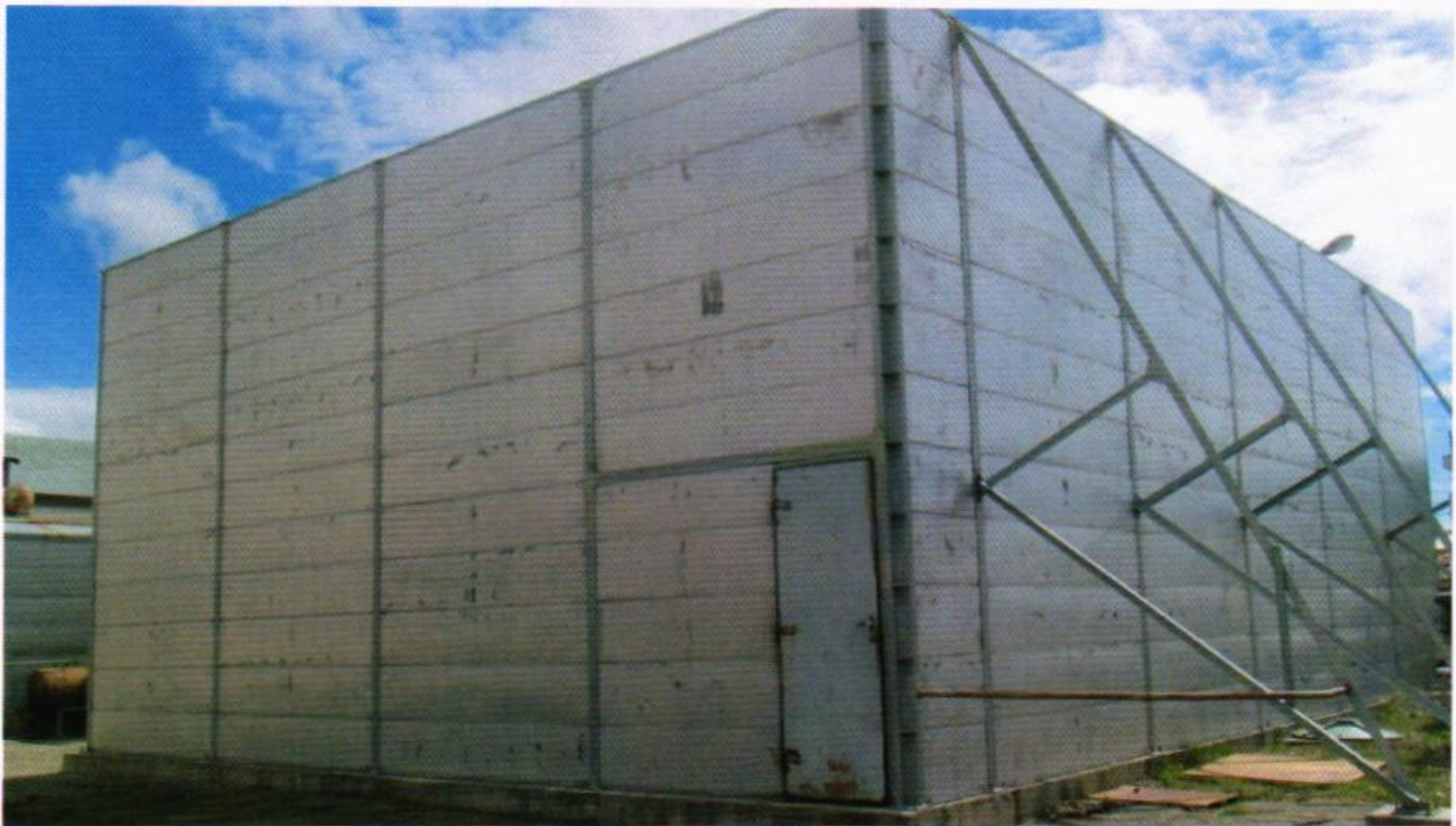
Figura 3: Panel insonorización Turbina GE N°4.
