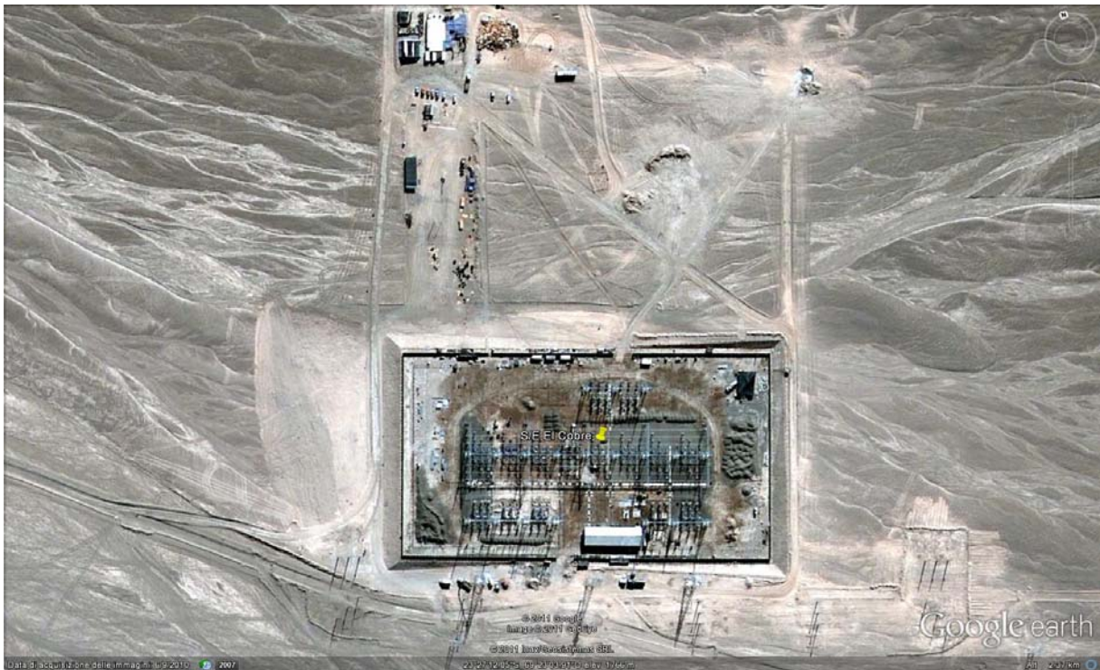
Figura 15: Vista de detalle de la S.E. El Cobre existente (a 220kV)
