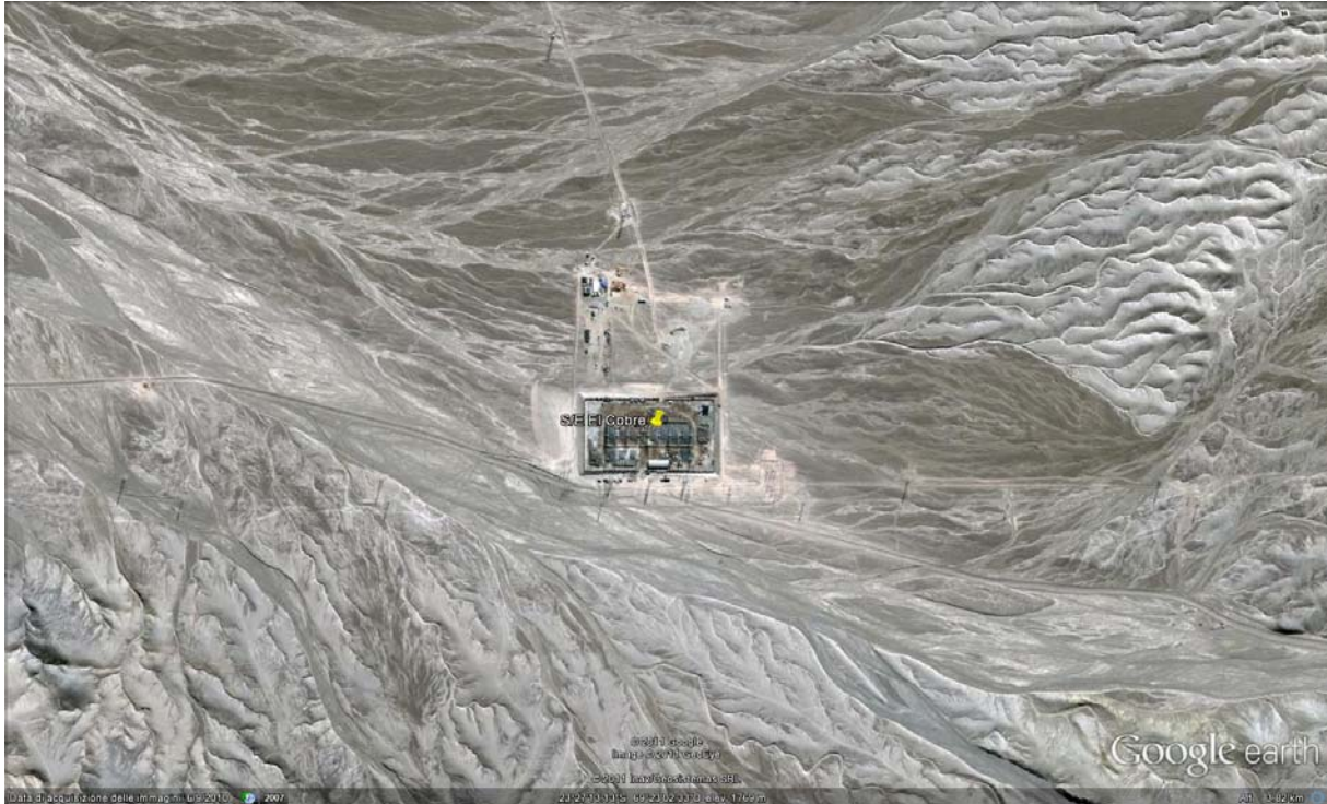
Figura 16: Vista ampliada de la zona de la S.E. El Cobre existente
