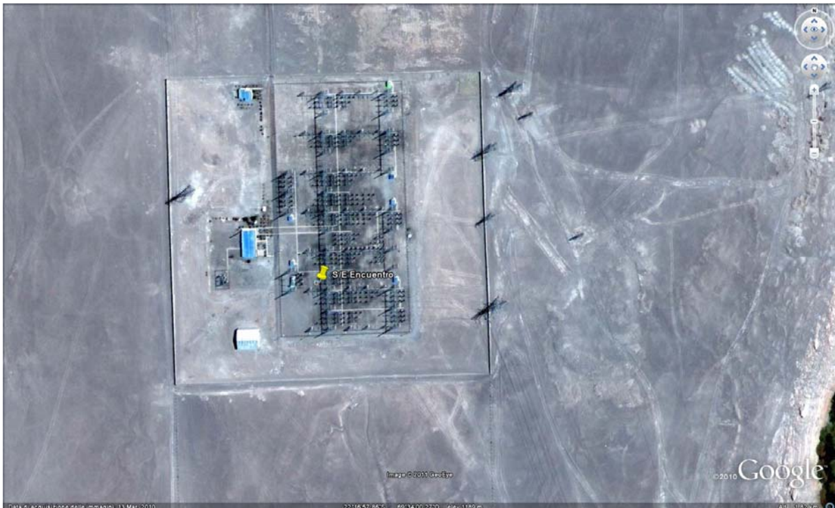
Figura 13: Vista de detalle de la S.E. Encuentro existente (a 220kV)
