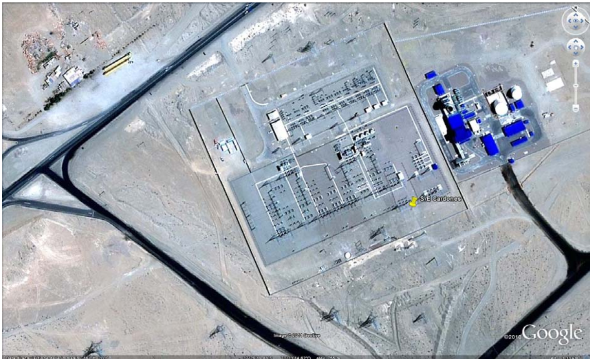
Figura 11: Vista de detalle de la S.E. Cardones existente (a 220kV)
