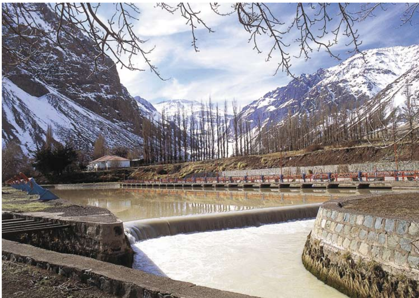
Central hidroeléctrica Quetebues
